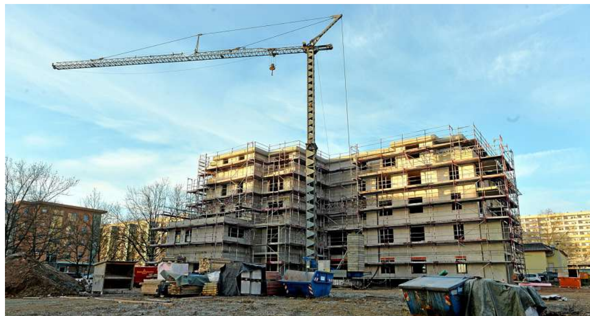
Blick auf die Baustelle in Lusan
