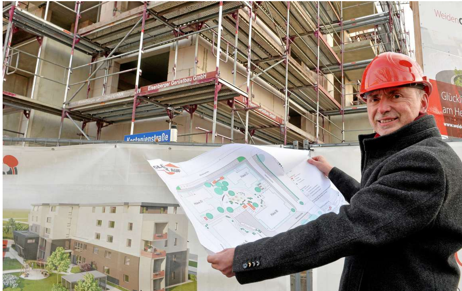
Uwe Klinger, Vorstandsvorsitzer der WBG „Glück Auf“, auf der Baustelle Weiden Carré in Lusan.
