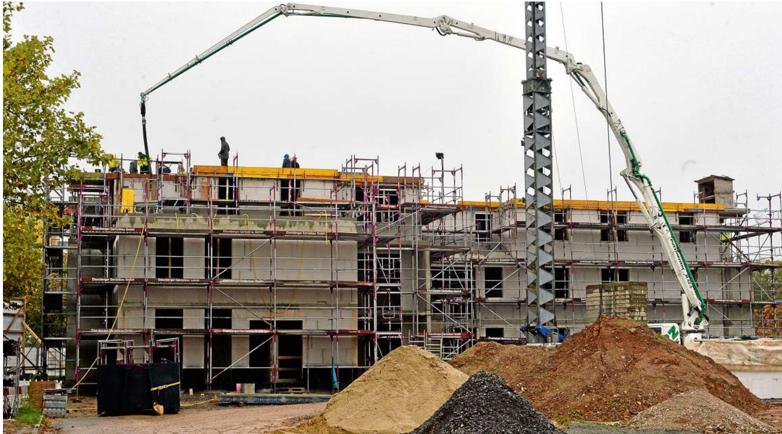
Im WeidenCarré in Lusan baut die Wohnungsbaugenossenschaft „Glück Auf“ in den ersten beiden Bauabschnitten zwei Häuser mit jeweils zehn Wohnungen sowie 22 Apartments für betreutes Wohnen.
