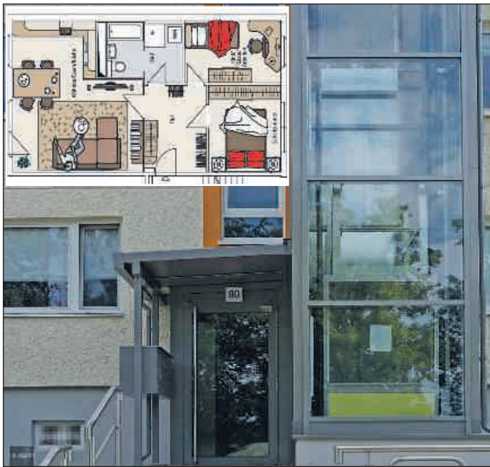
In der Karl-Wetzel-Straße werden barrierefreie Zugänge geschaffen und die Grundrisse verändert. Fotos: „Glück Auf“
