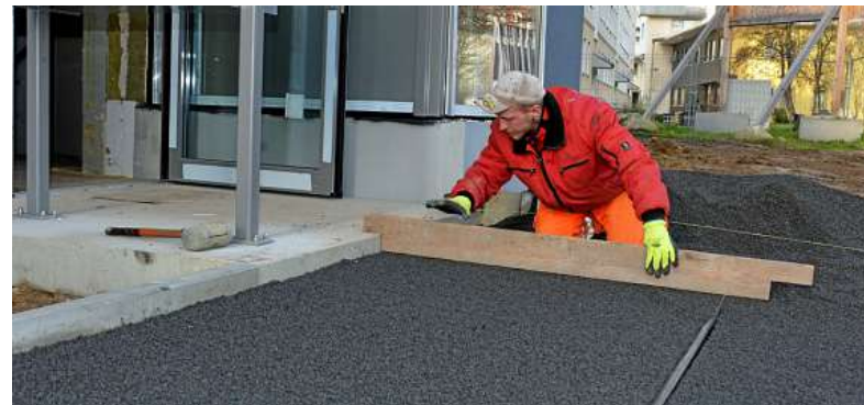
Ralf Procksch von der Firma TTW aus Weida war zuletzt noch mit Pflasterarbeiten beschäftigt.
