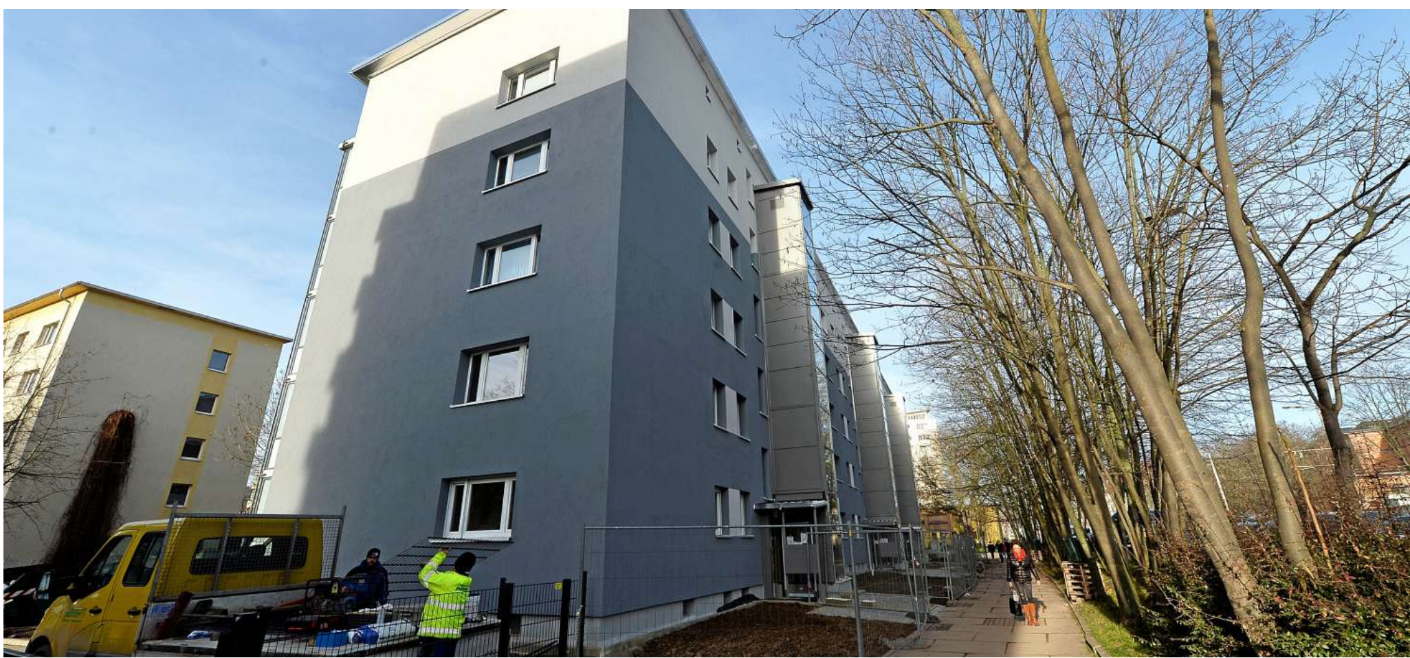
Die Sanierung des Hauses Reichsstraße 2d-f der WBG „Glück Auf“ ist bis auf Arbeiten im Außenbereich abgeschlossen.
