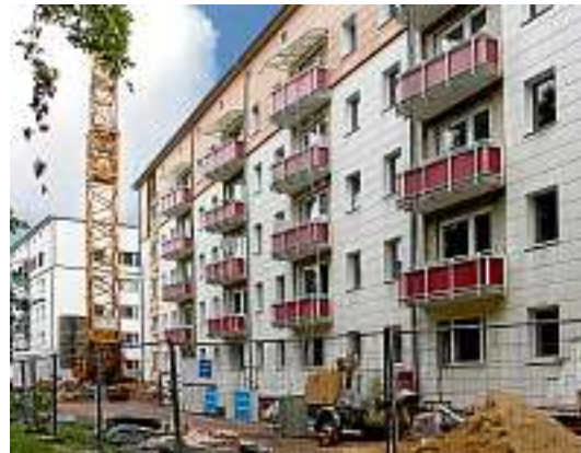
In der Reichsstraße werden Voraussetzungen für den Anbau neuer Balkone geschaffen. Foto: Sibylle Beer
