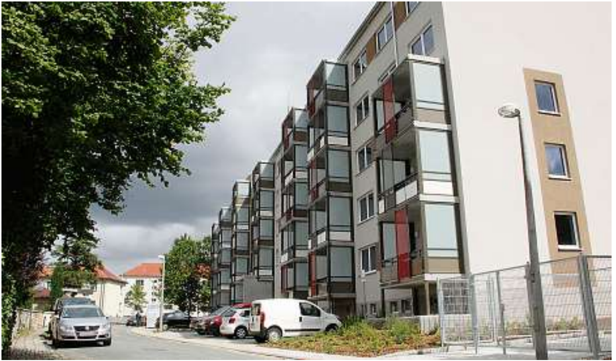
Auch die Außenansicht der Wohnblocks wurde deutlich aufgewertet.
