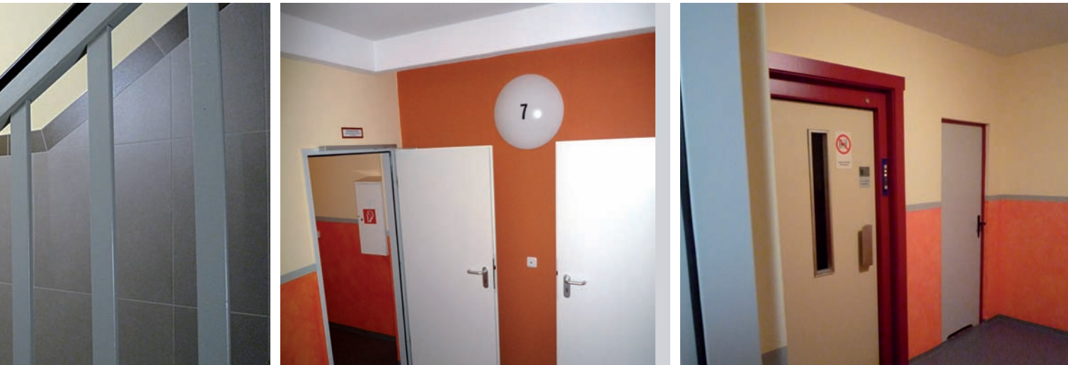
Treppenhaussanierung in der Berliner Straße 156
